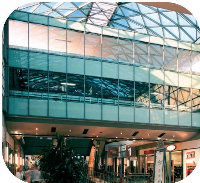
Fasada osłaniająca kładkę dla samochodów w Centrum Handlowym Promenada w Warszawie – Pilkington Pyrostop™ 30-10.
