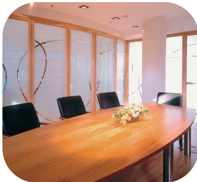
Drewniane ścianki działowe w biurcu Focus w Warszawie – Pilkington Pyrostop™ 30-201 piaskowany.
