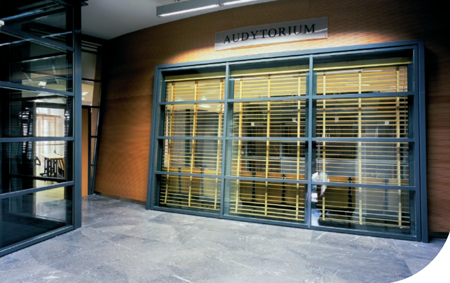
Szkło Pilkington Pyrostop ™ 60-171 zastosowane w wewnętrznej fasadzie Biblioteki Uniwersytetu Warszawskiego.
