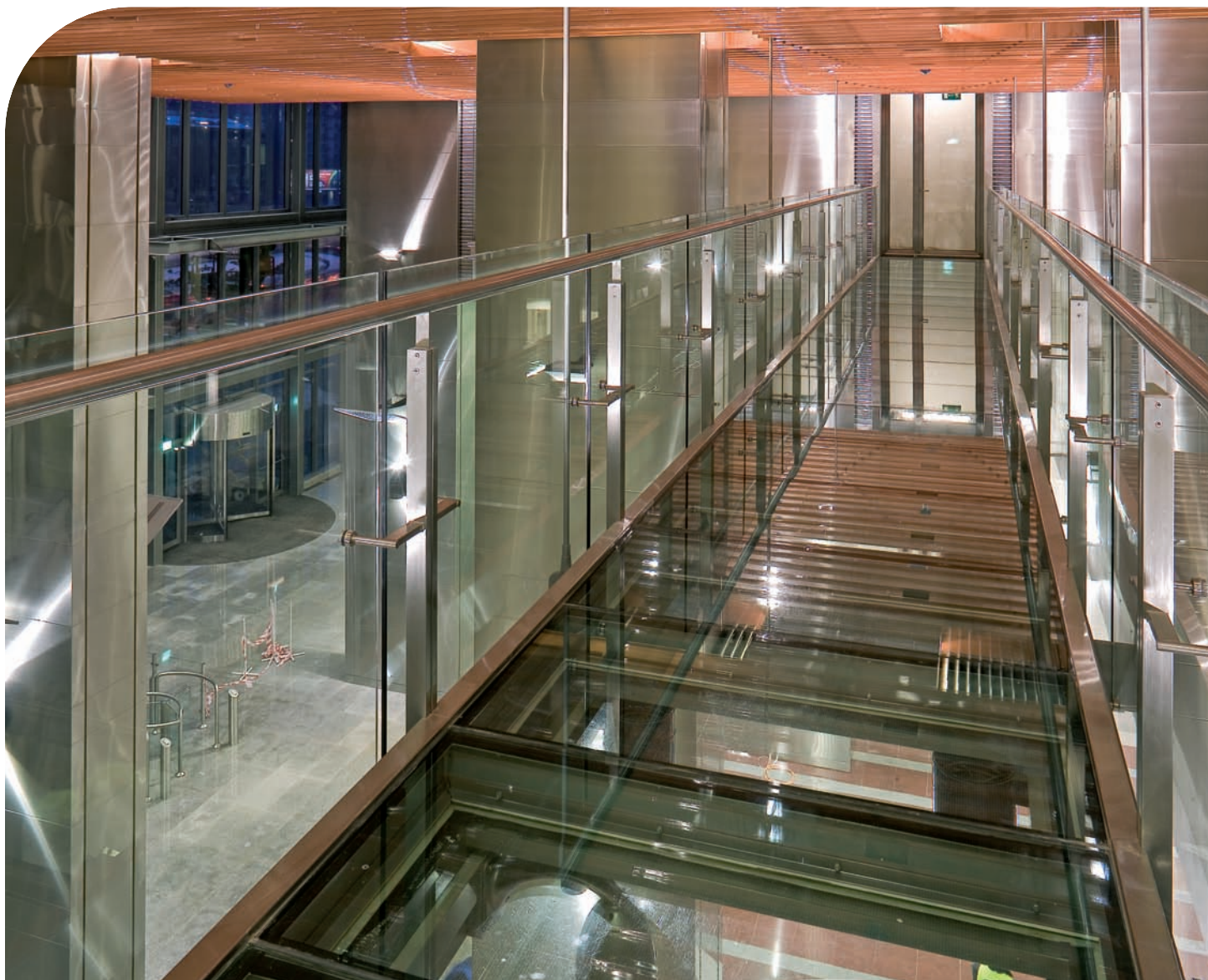
Do przeszklenia kładki pieszej w obiekcie biurowym Rondo 1 w Warszawie wykorzystano szkło Pilkington Pyrostop ™ 60-50.
